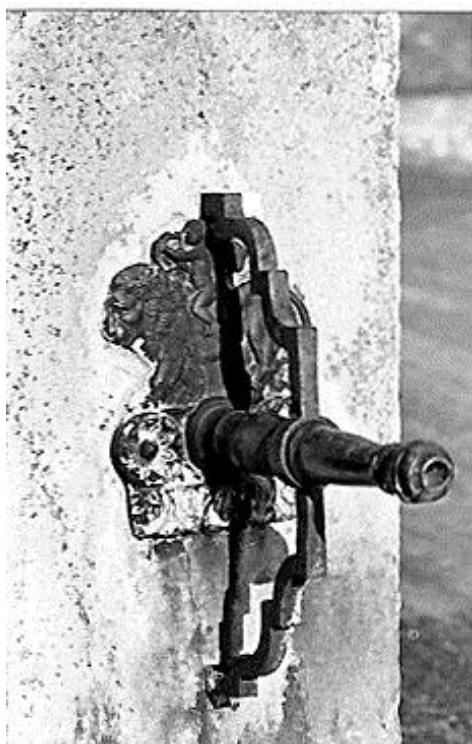
Das Röhrenschild mit einem Amor, der auf einem Löwen reitet ist restauriert und die alte Röhrenhalterung ist deswegen abgeändert worden.
