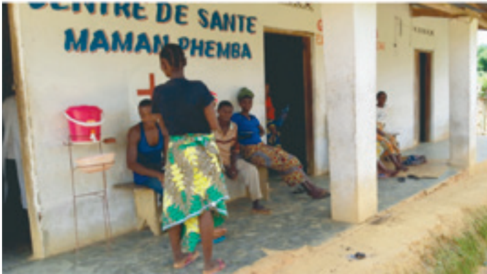
«Wartesaal» unter dem Vordach
