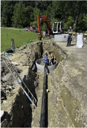
Einbau Druckreduzierung Schooss-Strasse
